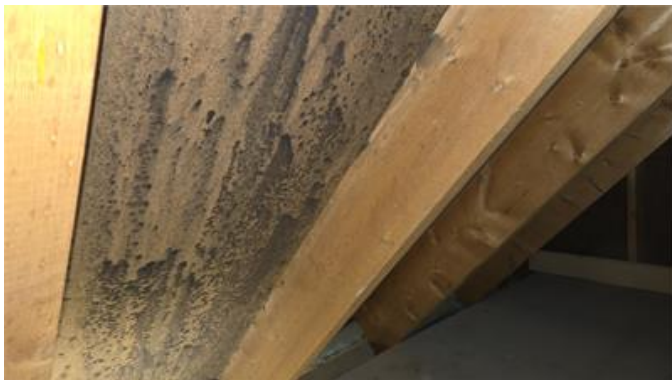
Bilden visar delar av vinden med missfärgningar på träfiberskivor
